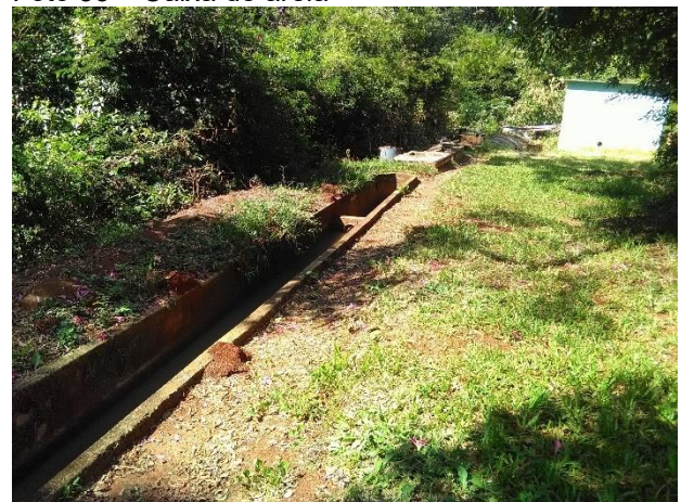
Foto 55 – Caixa de areia
