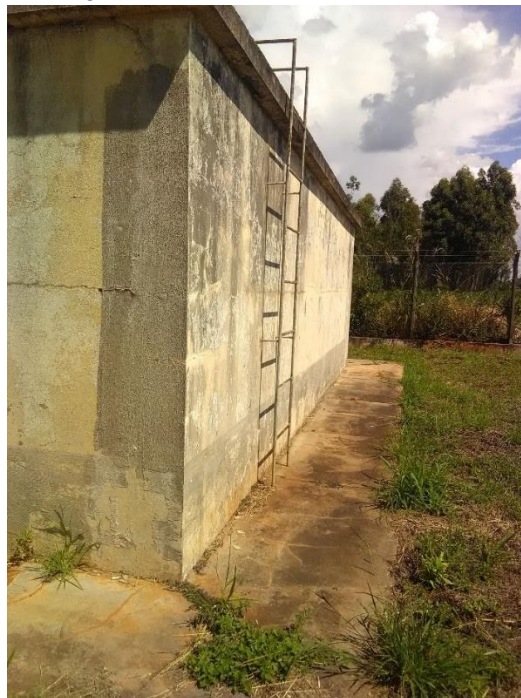
Foto 28 – Escada de acesso ao reservatório 100 m 3
