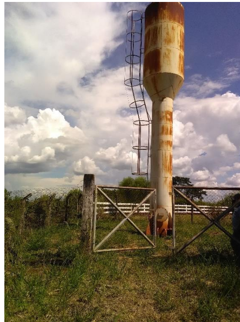
Foto 30 – Reservatório elevado Vila Rural
