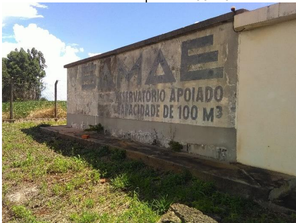
Foto 27 – Reservatório apoiado 100 m 3
