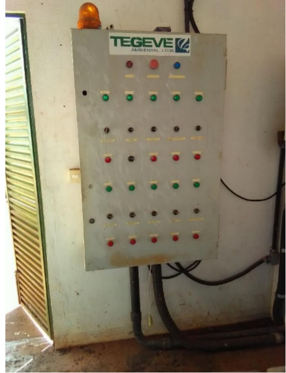
Foto 53 – Frente do quadro de comando da ETE
