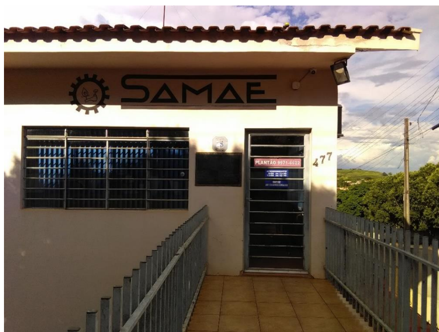
Foto 01 – Fachada área comercial
