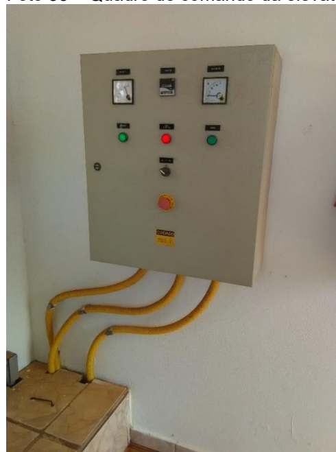
Foto 33 – Quadro de comando da elevatória
