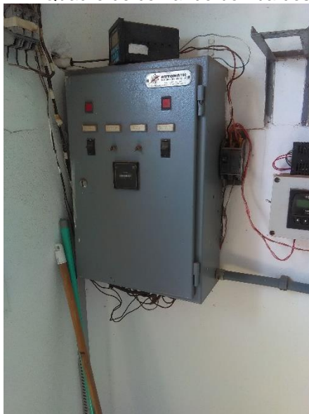
Foto 22 – Quadro de comando bomba dosadora
