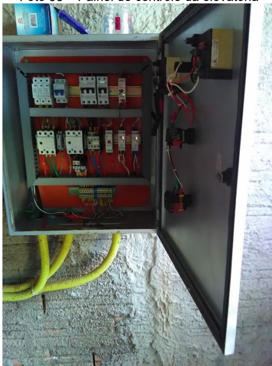
Foto 58 – Painel de controle da elevatória
