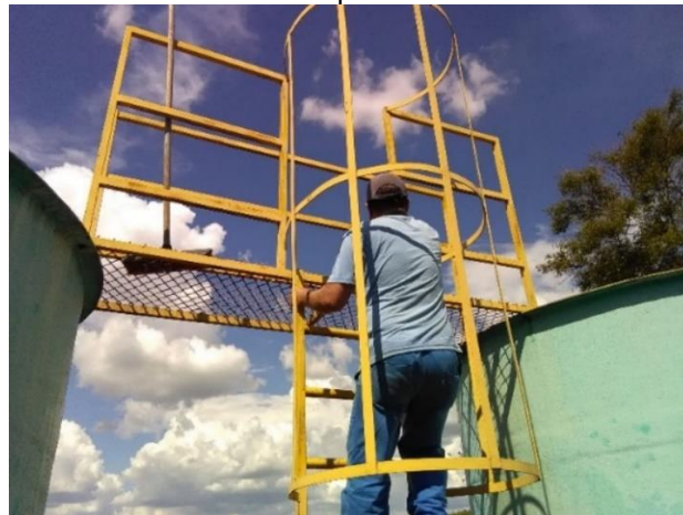
Foto 49 – Acesso ao tanque decantador
