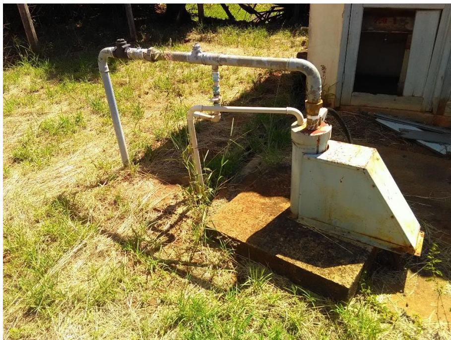
Foto 15 – Poço da Vila Rural
