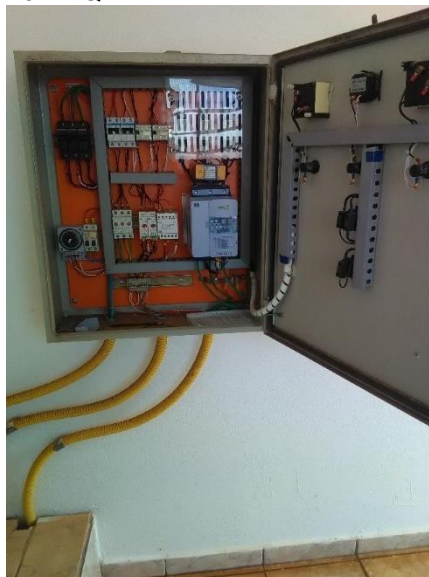
Foto 34 – Quadro de comando da elevatória
