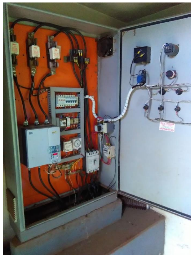
Foto 13 – Quadro de comando poços da Matilda
