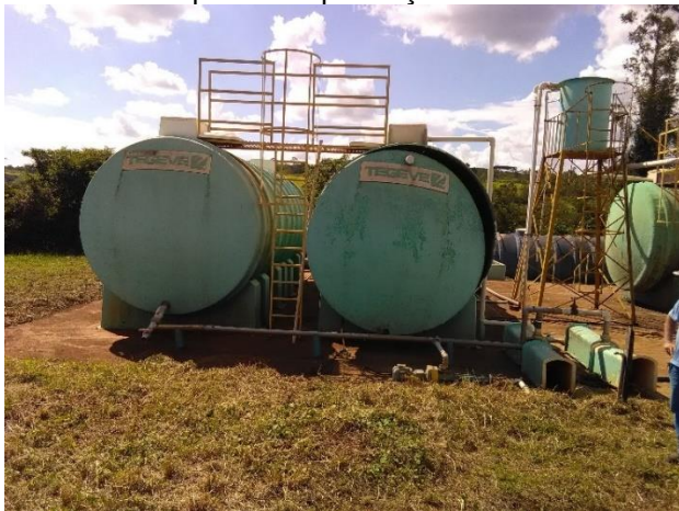
Foto 48 – Tanques de equalização
