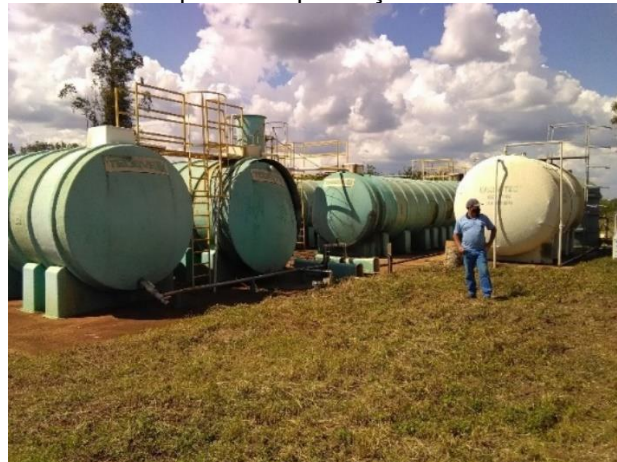
Foto 47 – Tanques de equalização e reatores
