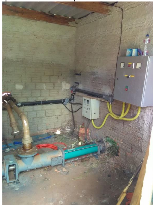
Foto 58 – Painel de controle da elevatória
