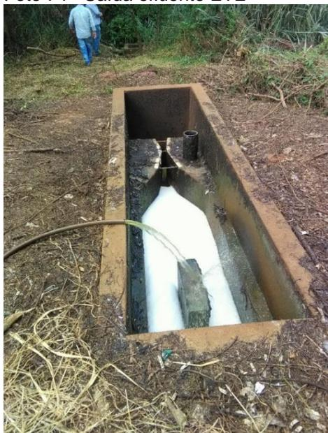
Foto 75 - Ponto de coleta de amostra na saída da ETE
